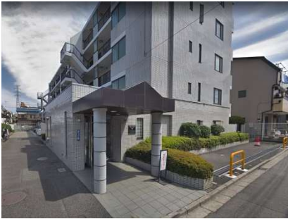
道路と敷地の高低差がない
