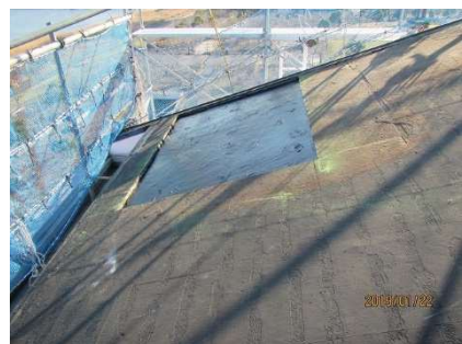
足場を設置し元仕様でしっかり補修
