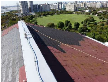
三角屋根の不燃シングル材・断熱材のスタイロフォームまで飛んだ状態
