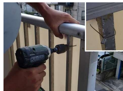
バルコニー内側からの留め工事
