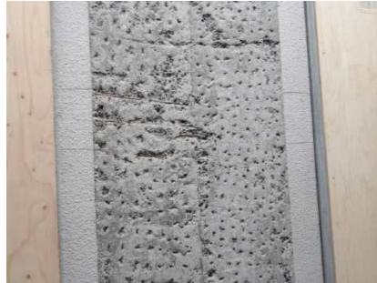
■7～8月：補強面目粗し、バルコニー既存鉄筋整備（新しい鉄筋を溶接する）
