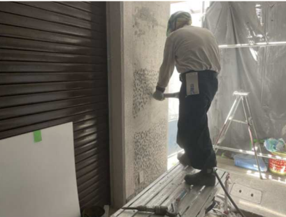
■7～8月：補強面目粗し、バルコニー既存鉄筋整備（新しい鉄筋を溶接する）
