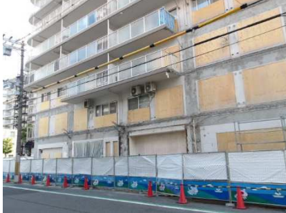
■6～7月：バルコニー解体、北壁面耐震スリット
