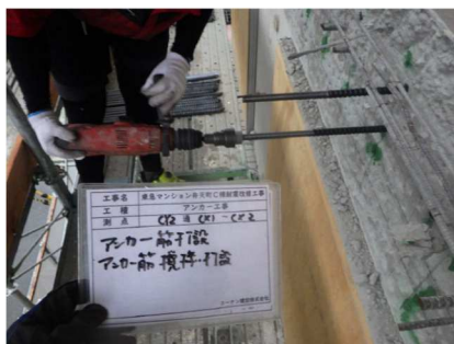
■7～8月：補強面目粗し、バルコニー既存鉄筋整備（新しい鉄筋を溶接する）
