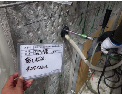
■8～9月：補強部アンカーボルト設置
