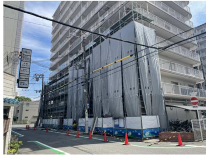
■6～7月：バルコニー解体、北壁面耐震スリット
