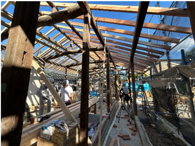
建て替えたほうが早いとせと大工さんに言われながら、丸太の屋根組を大事に残して元の力強さが蘇っていくのを実感
