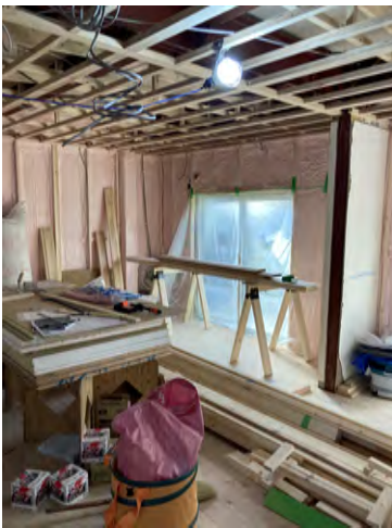
工事中的様子
