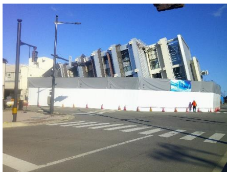
写 11 倒壊した五島屋ビル、解体工事開始
