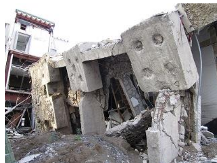
輪島 倒壊ビル
