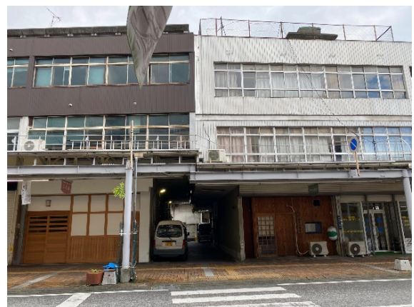
▲隣のビルの持ち出し梁でつながる建物
