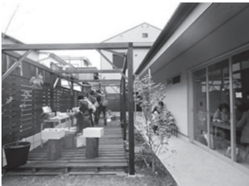
減築して各戸の裏庭を一体化して共用庭を設けた。テナントによるイベント利用などに使われる
