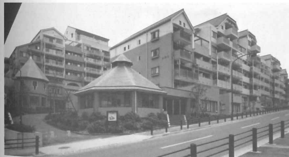
図1 全景 手前に集会所、その奥左に風見鶏文庫のある第2集会所。住棟は屋根を分割し、一つの建物であるが、いくつもの建物が集まっているように見えるデザインとしている
