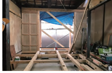
建屋の傾きを戻し、傷んだ梁や柱を取り替え補強の壁を増やしていきます。
