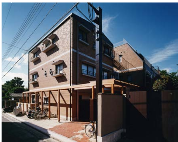
▲ 同社や付近の町並みを意識したレンガタイル貼りの外観
