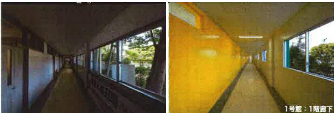
廊下 窓開口を制限し壁を補強しつつデザイン
