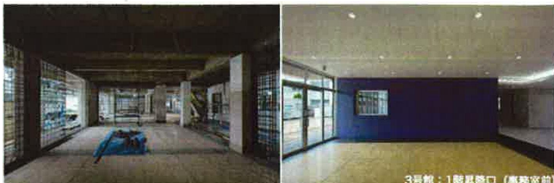
昇降口には大きな耐震壁を設けて補強
