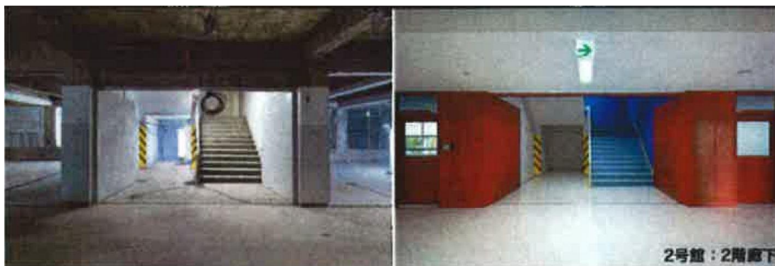
廊下階段部 必要な補強を加えつつデザイン
