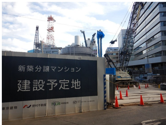
千葉「三越」跡地は杭・基礎工事が始まっている。道路向かいのNITビルも工事中だが、駅前から中央公園まで続く歩道の材質を変えとか、緑道化するとか、ひと工夫が欲しい
