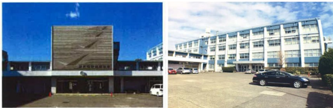
既存校舎外観
