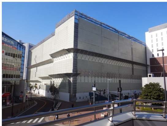
船橋駅前「西武」は解体工事中。駅前広場から続くペDESTリアンデッキは？
