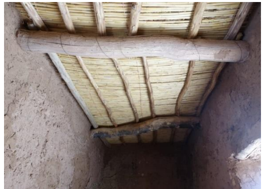
写真⑤建設中の日干しレンガの家
