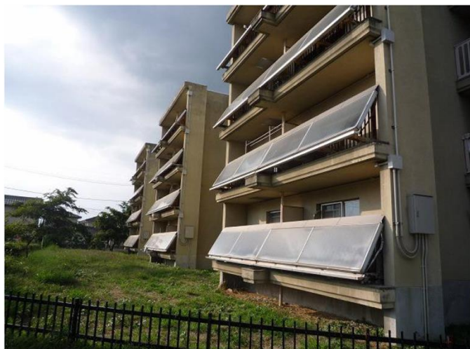
山梨県「石和団地」の太陽熱給湯パネル
