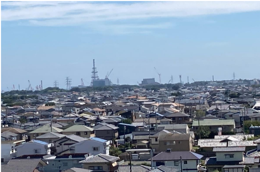
村庁舎屋上から見た原発。再稼働に向けた工事が進む。近くまで住宅が広がっている。
