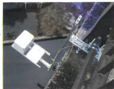
橋梁に設置するタイプ
