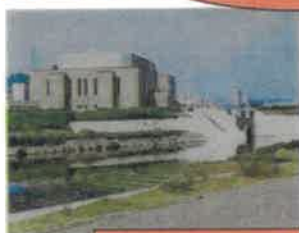
内水排除施設
