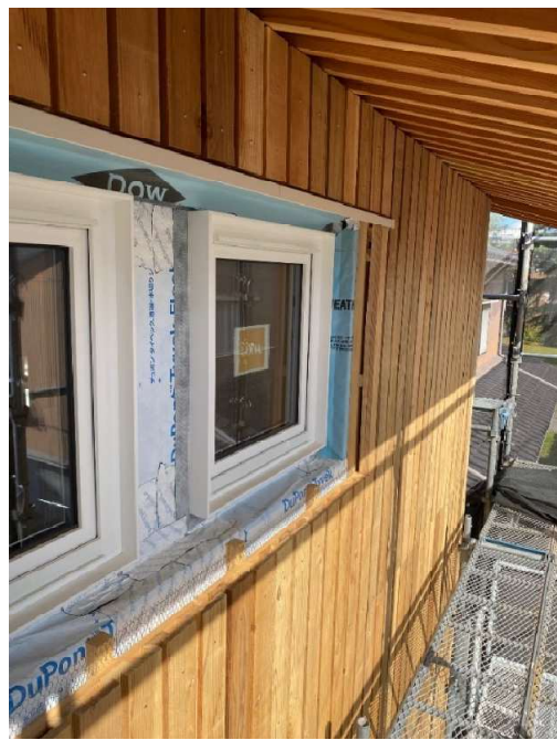
外断熱の為、サッシが内側にあり、止水の工夫
