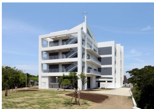
妻側に津波避難用屋外階段がある
