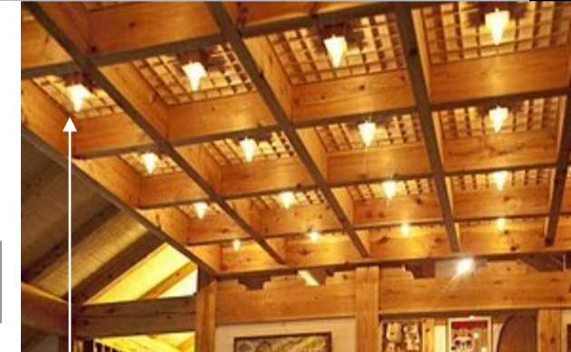
東西方向に走る梁を互につないで一本の長い梁とし、台所・風呂などの水回りを囲むコンクリート構造体とアンカーボルトで固定し、耐震性を増強した。
