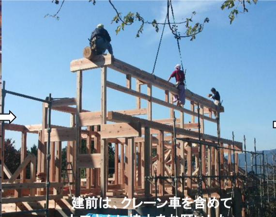
材木の刻みは、すべてコンピューター入力のプレカット。ただし、一部の複雑加工はプレカット屋さんの大工さんをお願いした。
