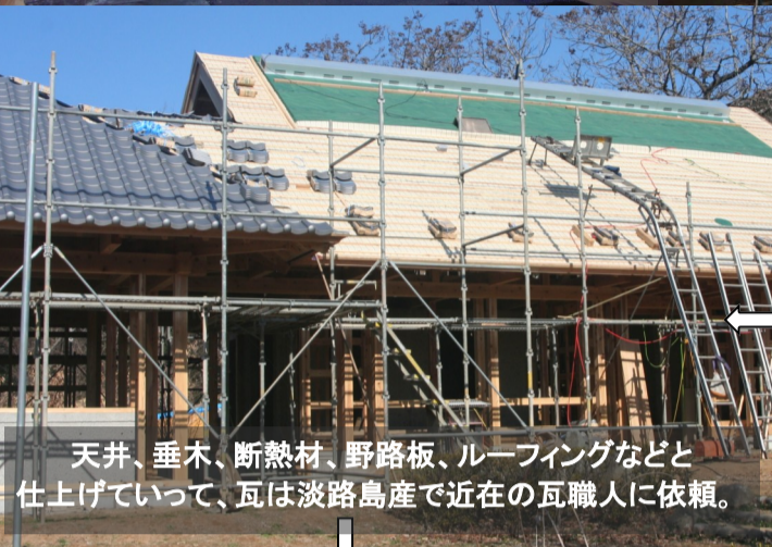
材木の刻みは、すべてコンピューター入力のプレカット。ただし、一部の複雑加工はプレカット屋さんの大工さんをお願いした。
