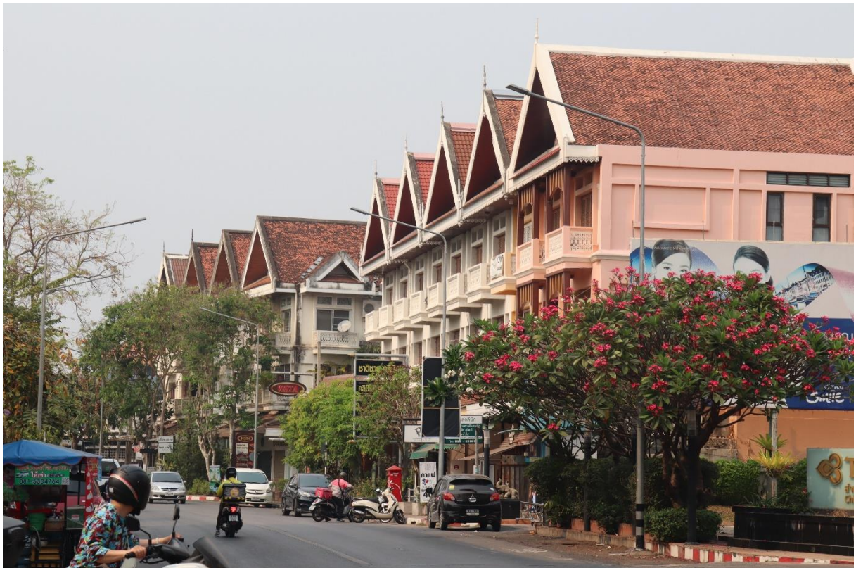
壁高 12m 規制の街並み。切妻の屋根がのっている。
