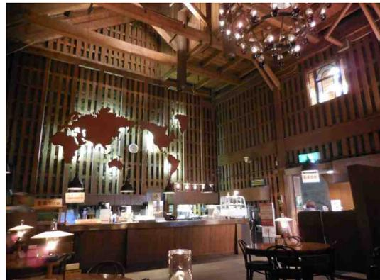
左は小樽運河沿い海側に並ぶ、木骨石造の倉庫、右は木骨石造建物の内部を改修した北一硝子「店舗内」木骨石造建築は、内部の木組構造体を外壁の石造部分にカスガイで固定し一体化した構法です。
