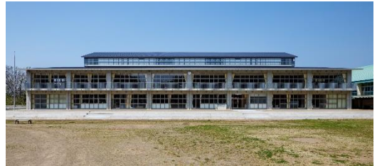
天羽中学校南側外観
