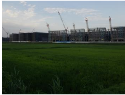
水田の向こうは物流センター工事中
