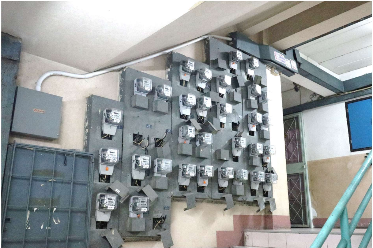
ニラン・レジデンス3。空家の電気メータは撤去されている。
