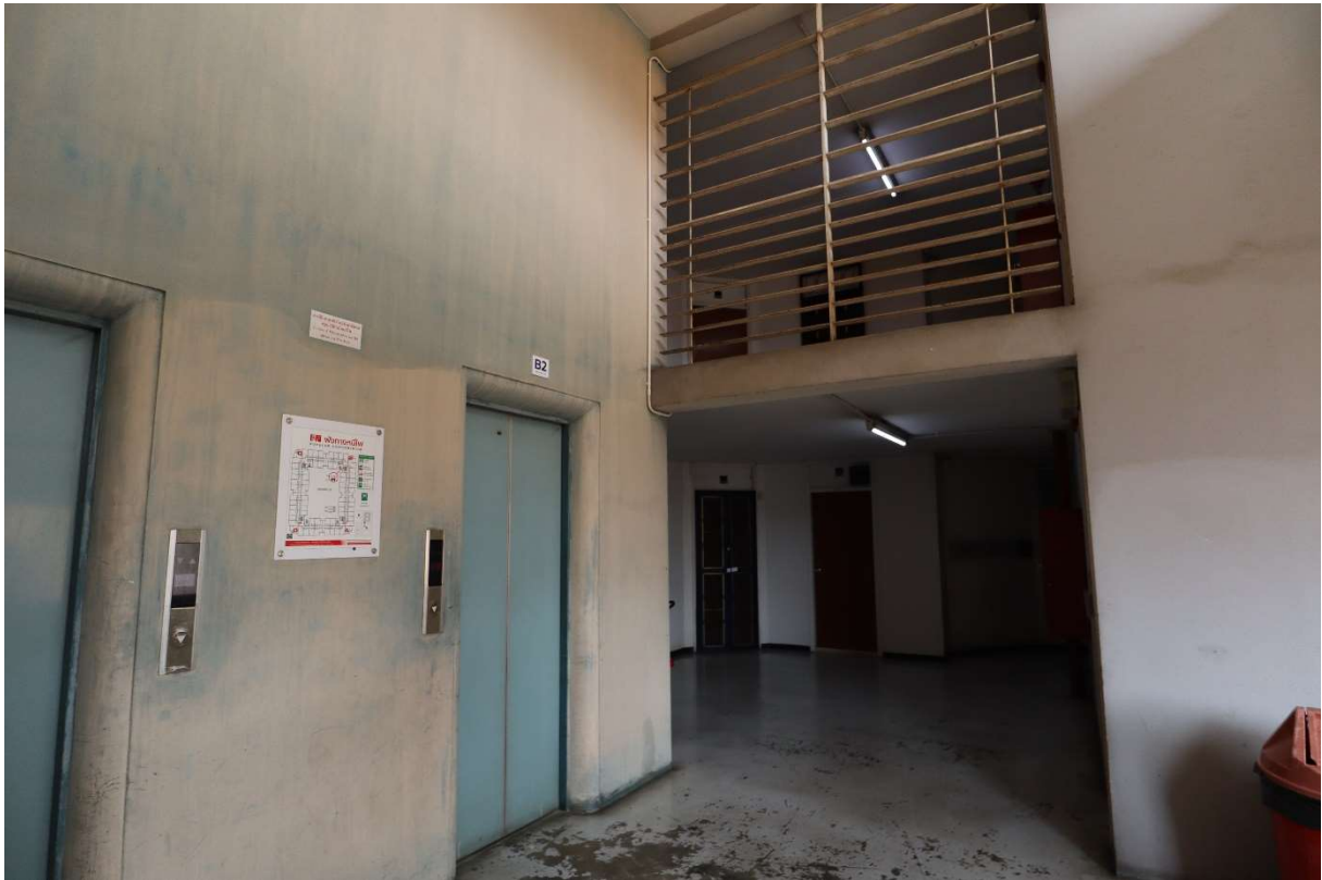
ポピュラー・コンドミニアムのエレベーターホール。隔階停止である。
