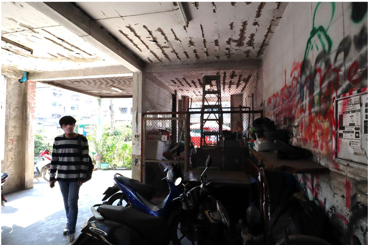
フラット・プラ・トン1階ピロティ。天井の鉄筋が露出している
