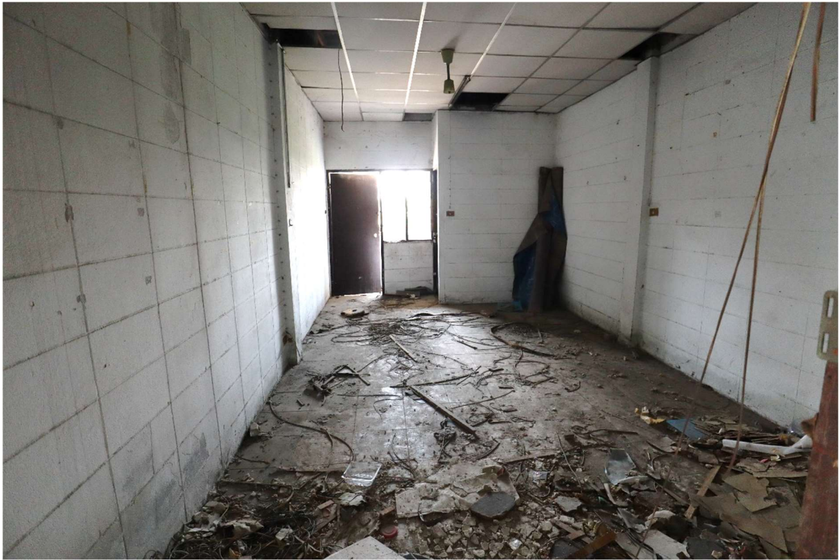
フラット・プラ・トン4階の空家住戸。劣化が著しい。
