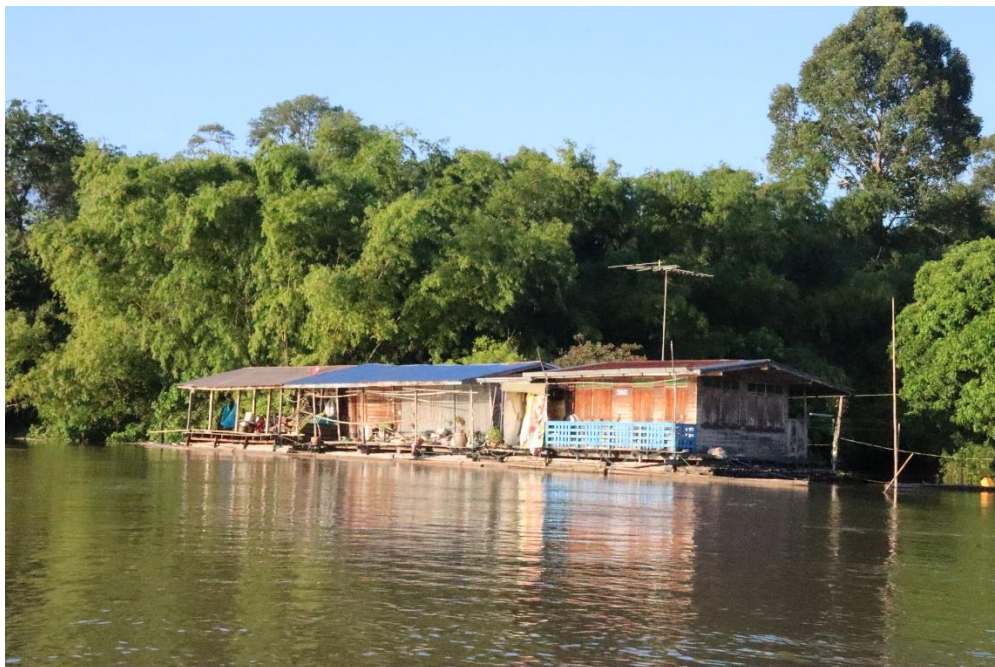
筏住宅の外観。3棟連なっている
