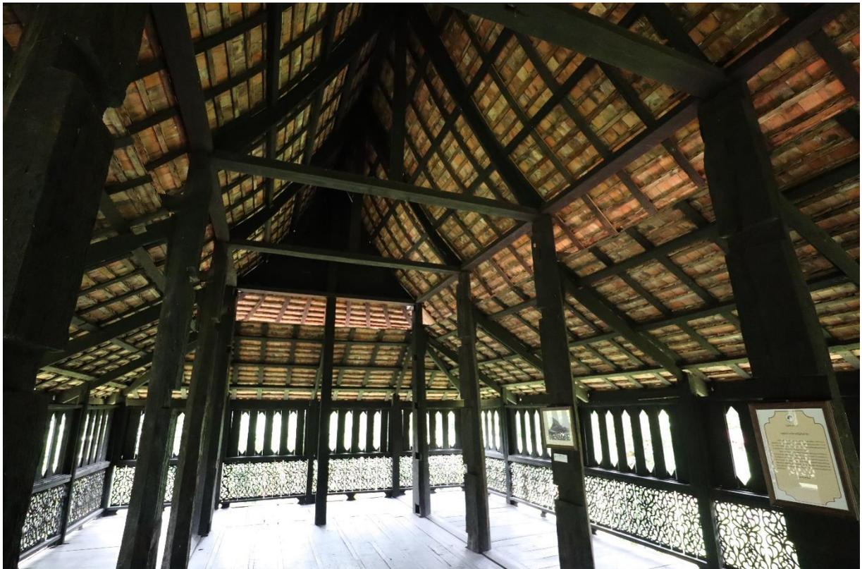
室内。瓦は棧に引っ掛けるもので、室内側にむき出しになっている
