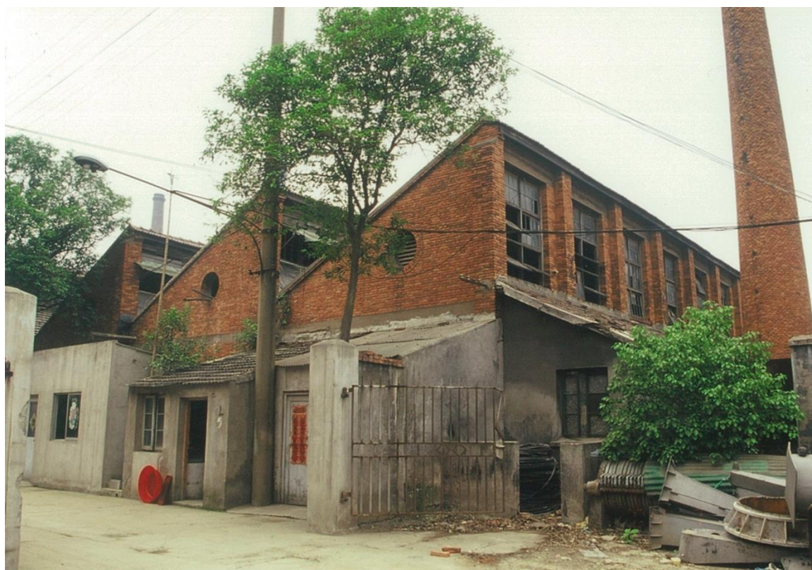
レンガ造 3 連鋸屋根：蘇州市同心紙製品工場 2004 年 6 月撮影
