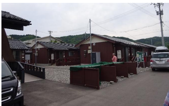
木造の仮設住宅 44 戸
