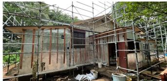
屋根は、既存の引掛桝の上に新しい垂木と野地板を形成し、その部分に断熱材・遮熱材を施工
