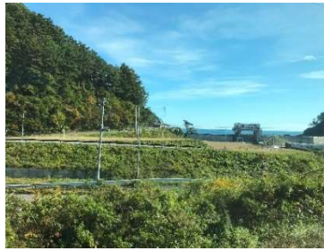
津波でも残った三陸鉄道の車両を模 った水門の機械室棟が遠く見える
