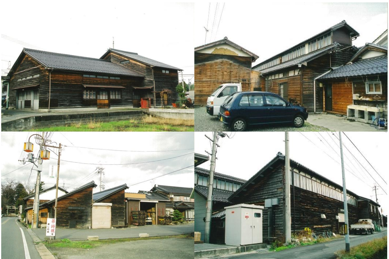
高島市新旭町藁園区の撚糸工場：2連鋸屋根工場と1連鋸屋根工場
