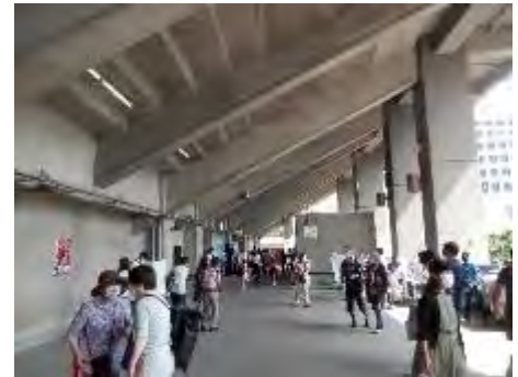
2階テラス、メインスタンド裏。コンクリート肌は古びていない。メインスタンドは一部補強が必要だが全体的に耐震改修の必要はない。
