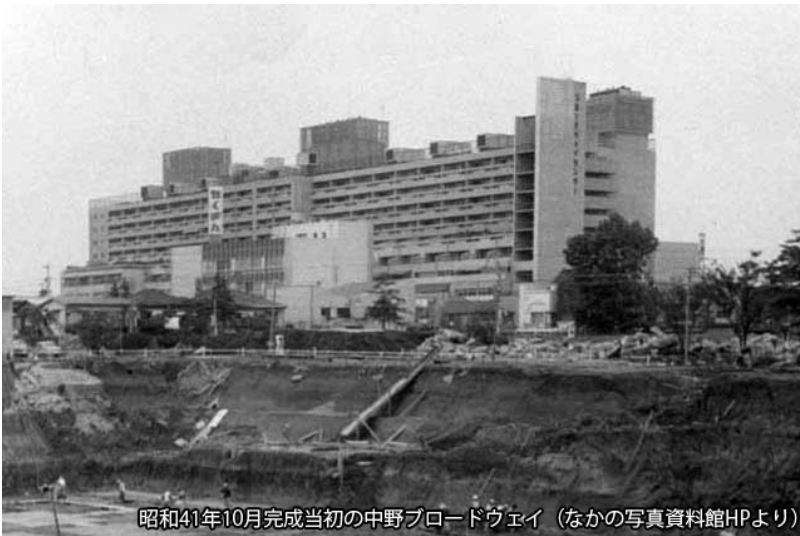
「中野ブロードウェイ建設時の写真」検索結果から (手前は、地下掘削中の中野サンプラザ)
