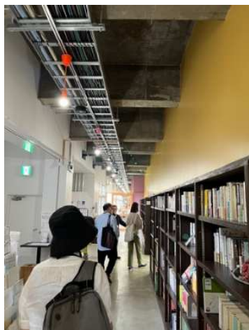
構造を現した開放的な空間
