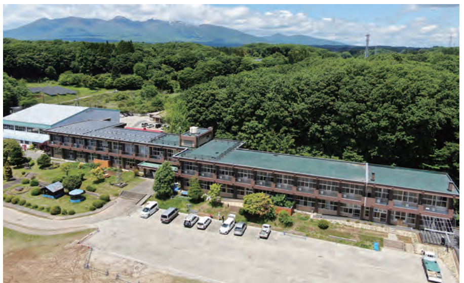
写真1 文化交流館（旧校舎）全景
