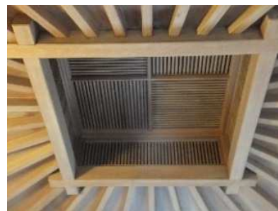
天井換気口室
