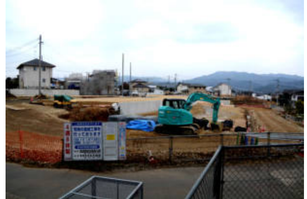
住民合意が不十分なまま進められている「木山土地区画整理事業」の工事
