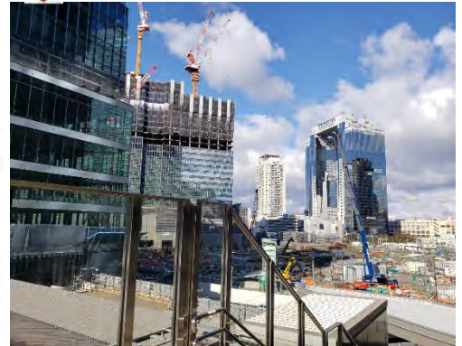
うめきた東棟工事
